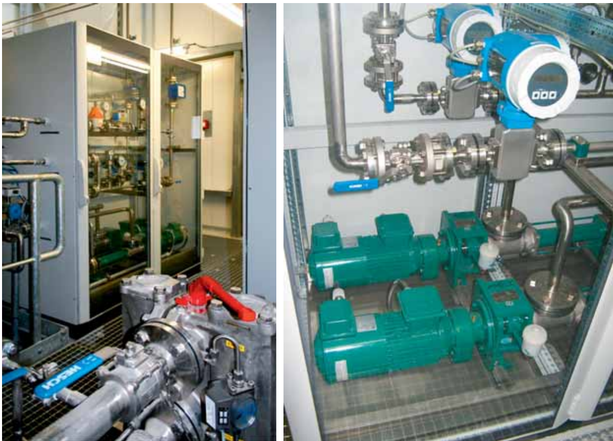
Bild 8: Misch- und Messmodul mit Transferpumpen für Drehrohröfen
