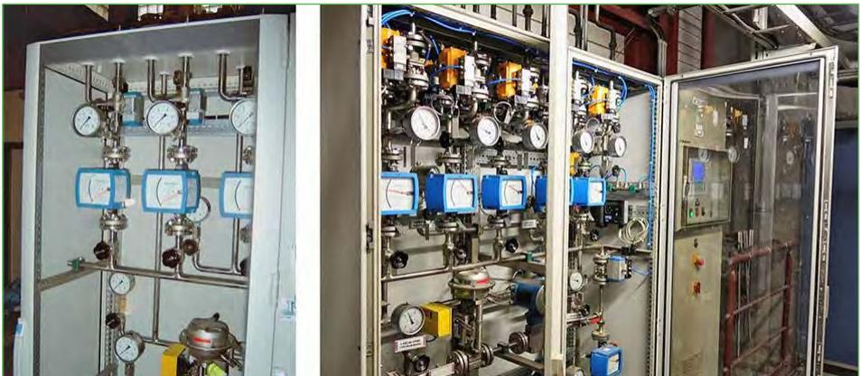
Bild 9: Misch- und Messmodule im ursprünglichen Zustand (links) und nach Umrüstung (rechts)
