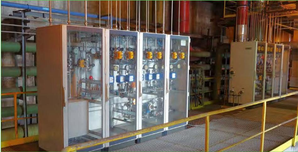
Bild 19: Typisches Misch- und Messmodul für einen kohlegefeuerten Kessel
