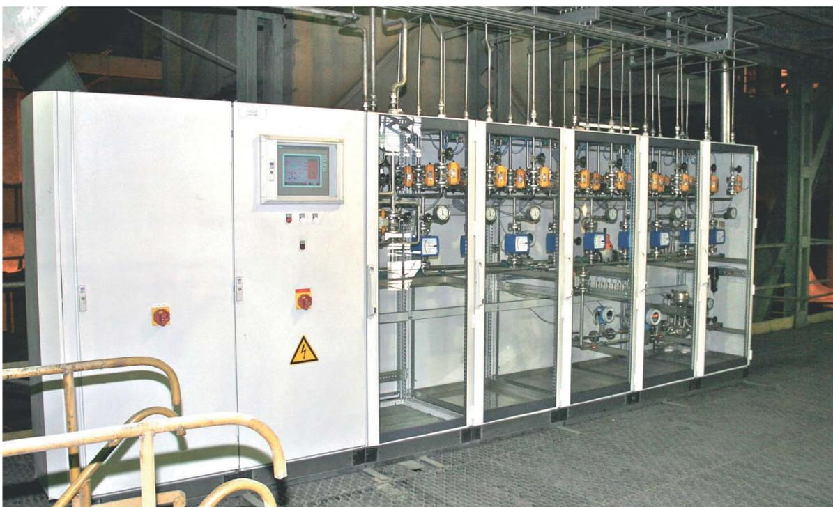
Abb. 11: Typisches Misch- und Messmodul für einen mit Kohle gefeuerten Kessel
