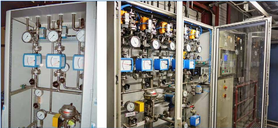
Bild 10: Misch- und Messmodule im ursprünglichen Zustand (links) und nach Umrüstung (rechts)
