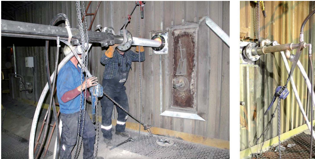
Abb. 11: Standort A – Einsetzen von In-Furnace Lanzen
