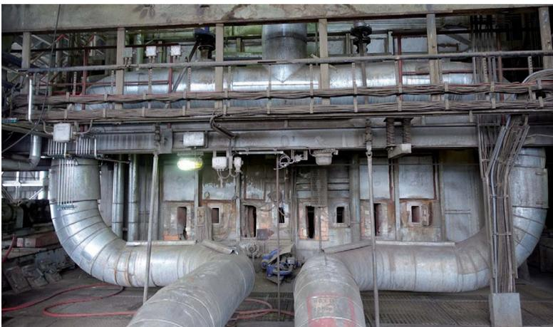
Abb. 9: Obere Eindüsebene vor Einbau der Lanzen
