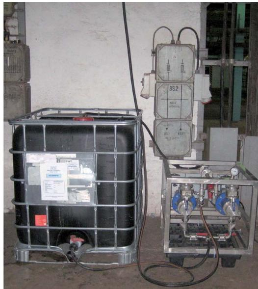
Abb. 4: NO<sub>x</sub>-AMID-Behälter und Pumpenmodul
