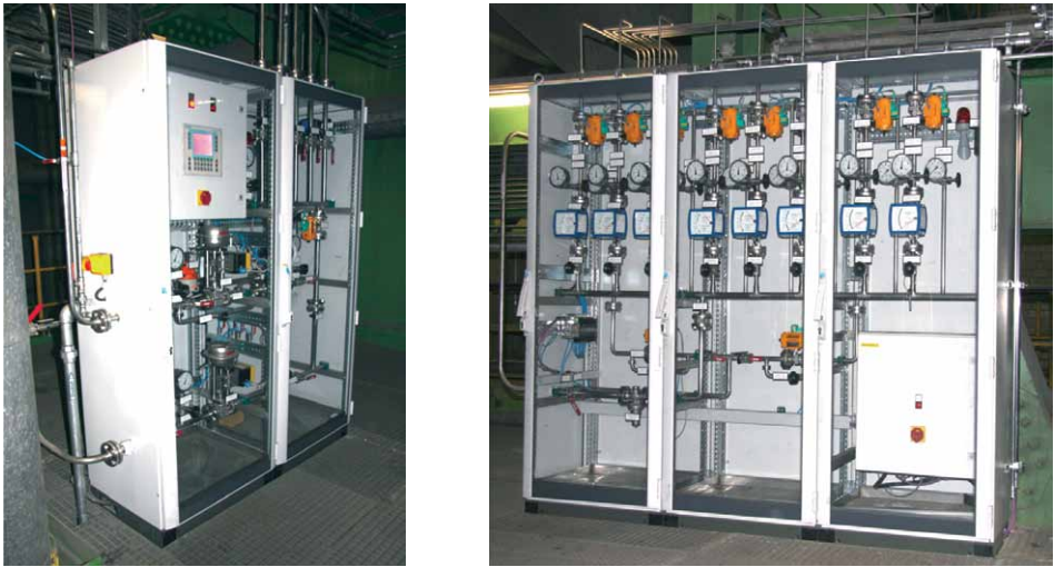
Bild 11: Misch- und Messmodul (links), Verteilermodul (rechts)
